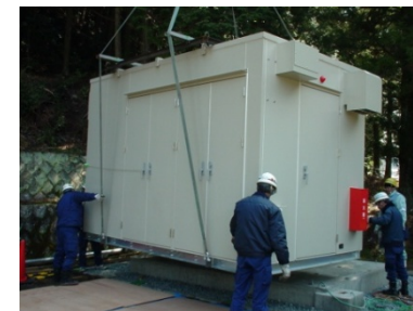
大型アッセンブリー
