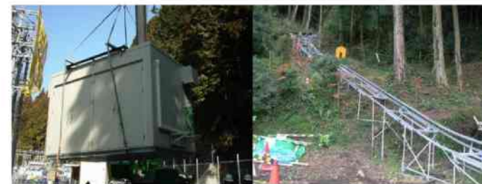
大型アッセンブリー 現地据付
